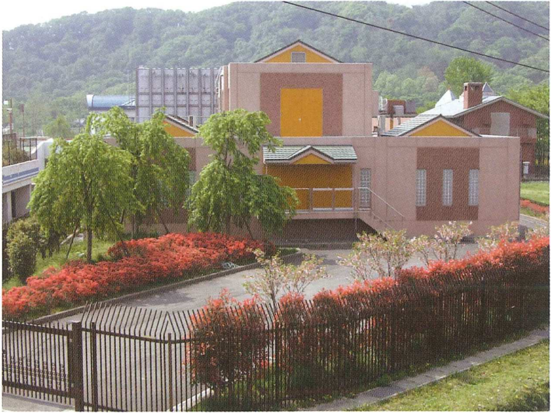
▲膜ろ過施設 (平成16年3月完成)
